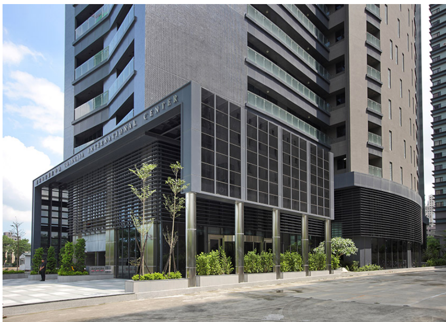
(親家建設 T3-市政國際中心建築物外觀，公會會所位於 22 樓)
