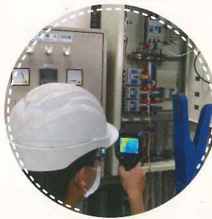
電力盤熱點量測
